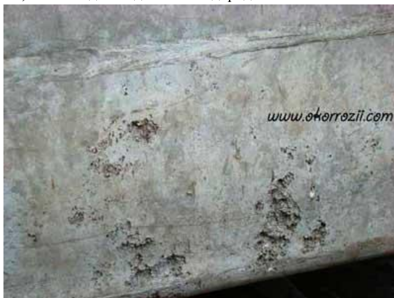
Рис. 1. Питтинговая коррозия алюминиевого сплава.
